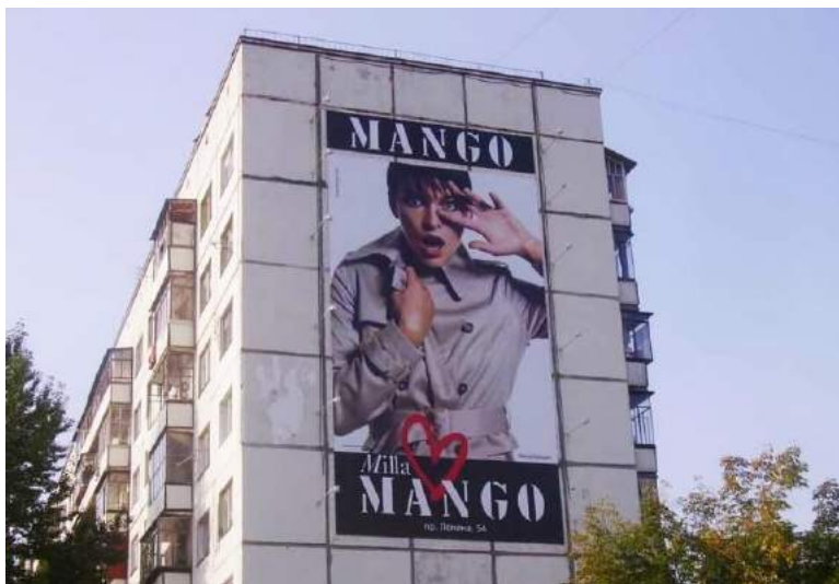
Рекламная конструкция - баннер на боковом глухом фасаде МЖД
