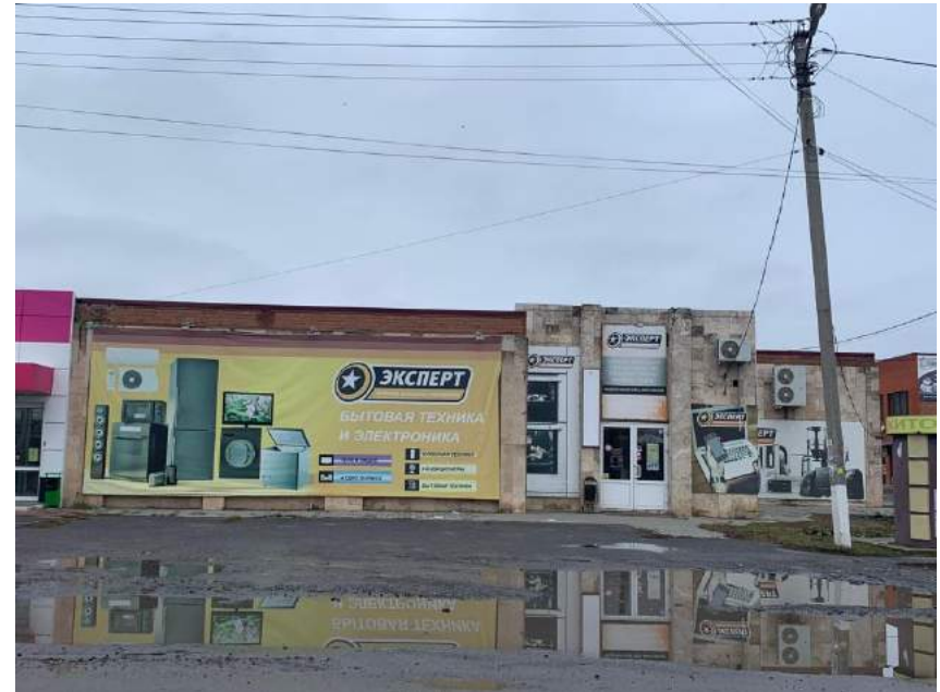
Избыточная реклама магазина. Фасад здания закрыт на 90%. Вывески перемешаны с рекламой. ул. Калинина - 15-й Переулок
