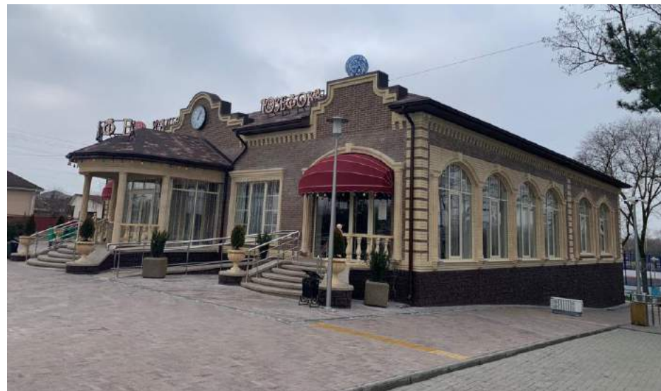
Примеры выполнения фасада в бежево-коричневых тонах. пр. В.А. Закруткина.
