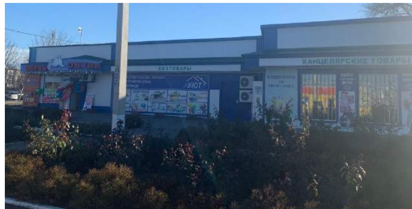
Вывеска занимает собой целый этаж. Недопустимо перекрытие оконных и дверных проемов, витрин, витражей.... Перекрывать детали архитектуры
